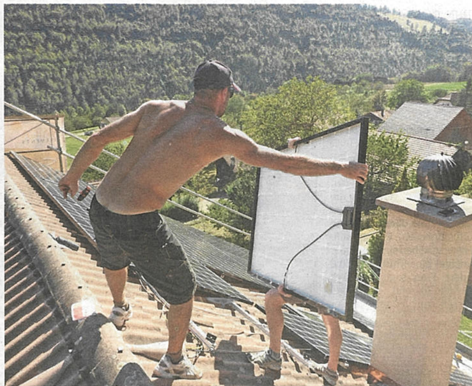
Saubere Energie: Eine Solaranlage wird auf einem Dach in Mettembert montiert. DIRK JUNGHANS
